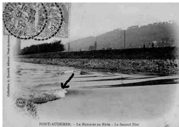
(d) Mascaret/bore River Risle; breaking/nonbreaking. Courtesy: Malandain '88
